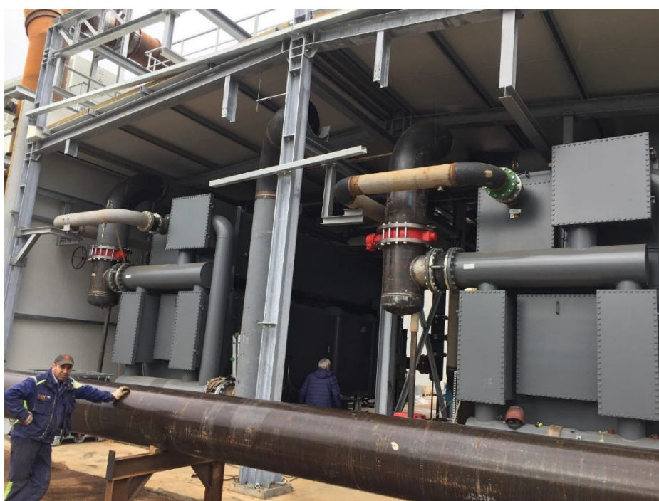
Trigenerazione FCA Cassino : n°2 Assorbitori a Bromuro di Litio da 4,5 MWf
