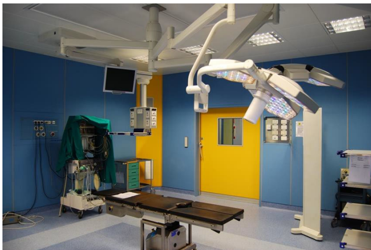
Clinica Ulivella Firenze: Interni sala operatoria
