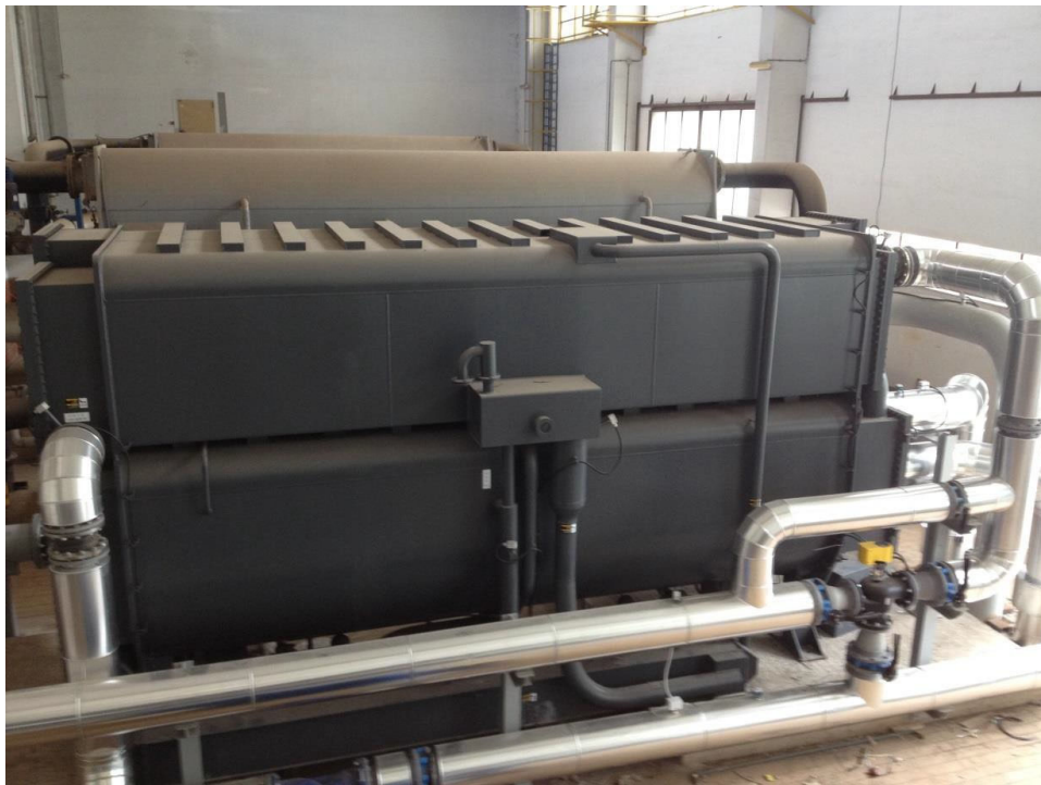
Trigenerazione Policlinico Messina: Assorbitore a Bromuro di Litio da 2400 kWf
