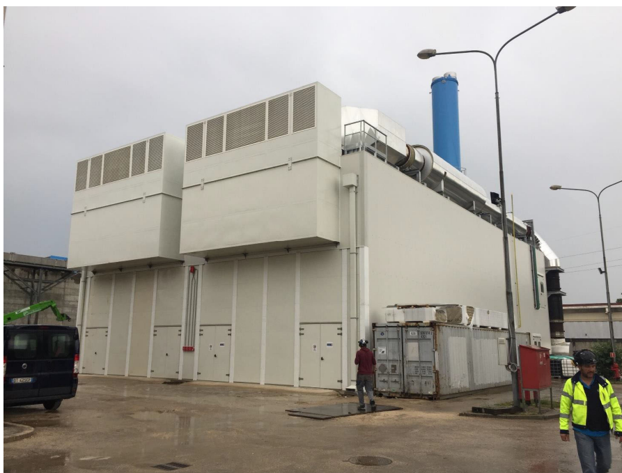
Trigenerazione FCA Cassino : Sala Macchine insonorizzata 65 dBa a 10 mt
