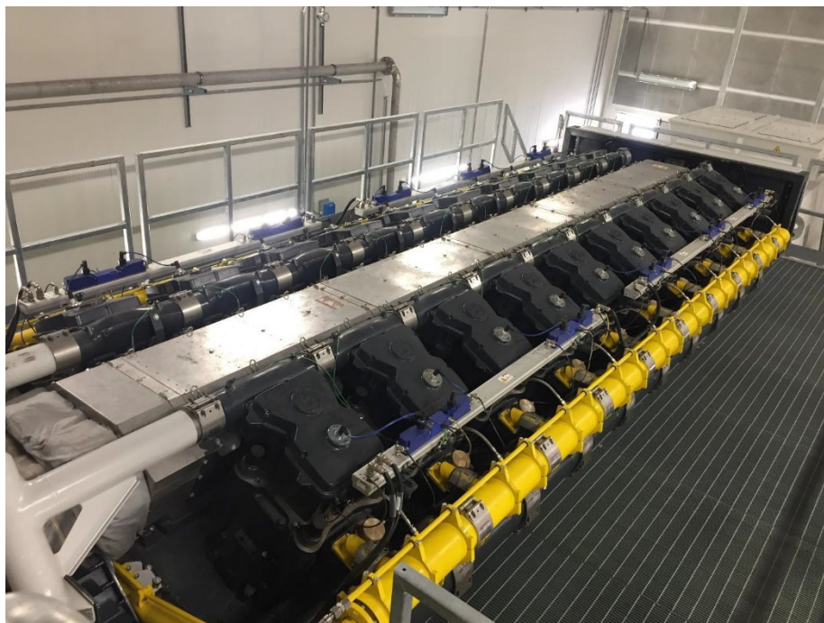
Trigenerazione FCA Cassino : Vista testata motore J920 (n°20 cilindri)
