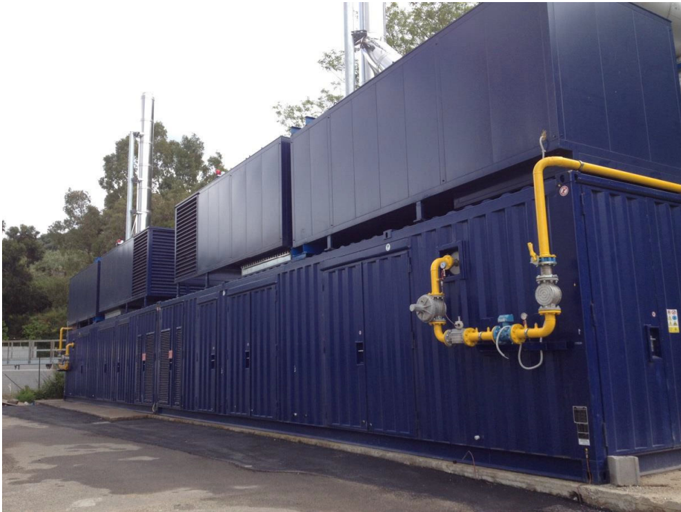
Trigenerazione Policlinico Messina : Cofanatura insonorizzata 65 Db a 10 mt
