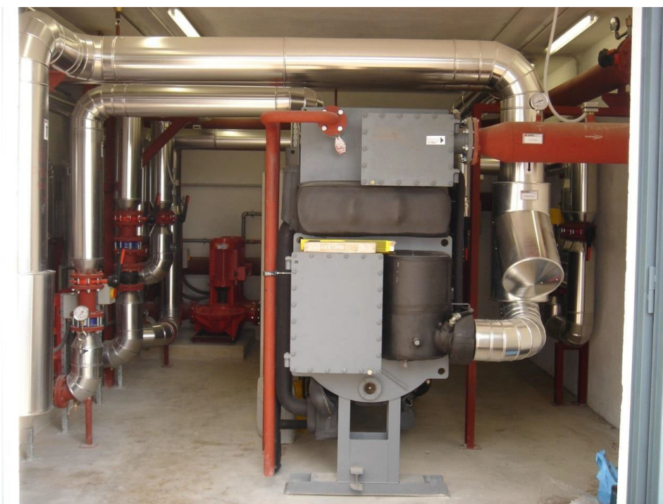
Impianto trigenerazione ICOT Latina: Assorbitore a bromuro di litio da 500 kWf
