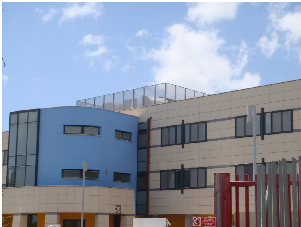
RSA ICOT Latina: Vista nuovo edificio
